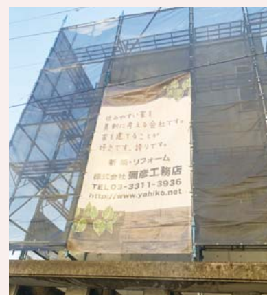
リフォーム施工
